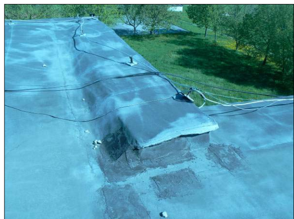
Pohľad na asfaltovú krytinu plochej strechy po viacnásobnom prelepovaní
